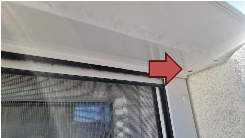
Dann kann man mit den Fingern unter die schwarze Borstenleiste greifen und die Abdeckung nach unten klappen. Links und rechts waren die Borsten ein wenig eingeklemmt, aber mit Gefühl geht es
