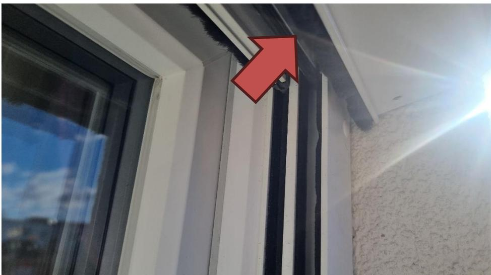
Wenn die Lamellen fast ganz unten sind, sieht man diesen Verschluss. Mit einem flachen Schraubenzieher kann man die schwarze Plasticschiene (1) leicht anheben und den ganzen schwarzen Plastikteil nach rechts schieben (2). Dieser lässt sich ca. 3mm verschieben und kann dann nach oben weggeklappt werden. Somit kann man die Lamellen aushängen
